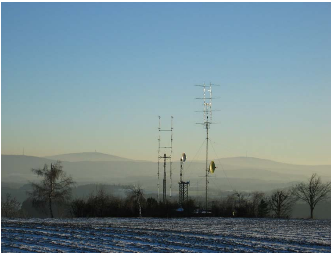
Die Antennenanlage im Winter 2003. Um die Windlast zu verringern ist die 70cm Antenne eingefahren!
